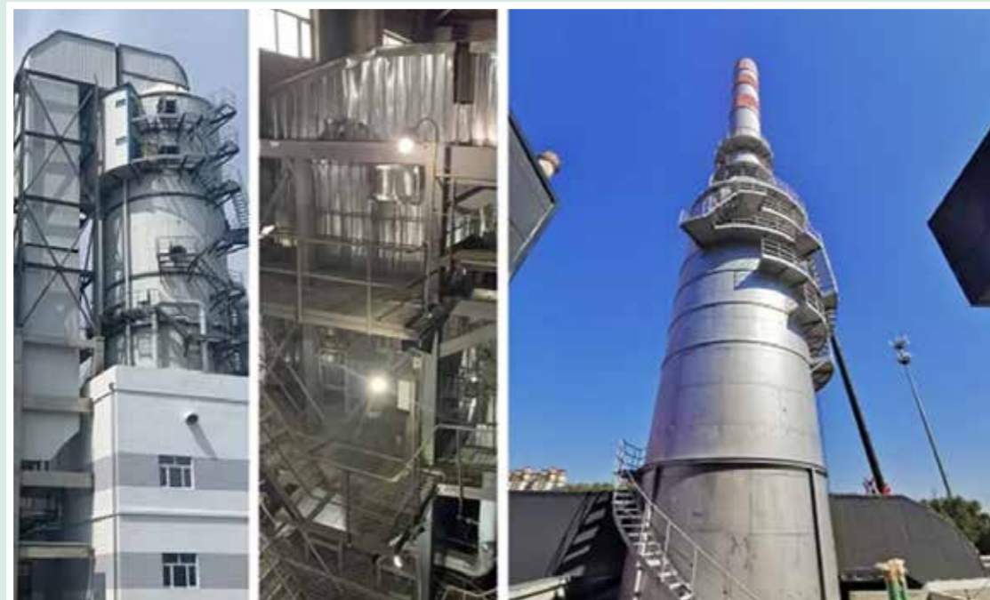
哈成套与 CMEC 联合研发的科研项目《燃煤电站锅炉多污染物联合脱除技术与装备》
