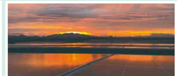
光伏电站清晨
