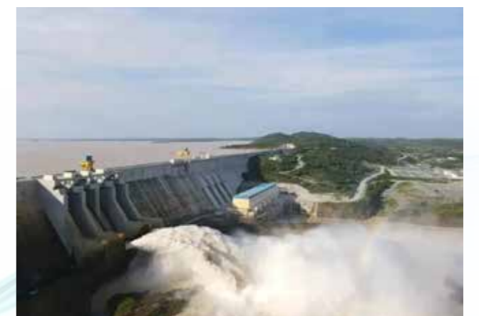
尼日利亚宗格鲁水电站项目完成移交
