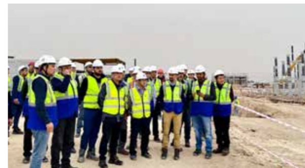
方彦水总经理检查乌兹别克斯坦谢拉巴德 500MW 光伏电站的安全生产工作
