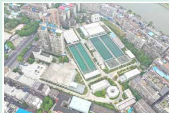
衡阳市演武坪水厂提质改造项目
